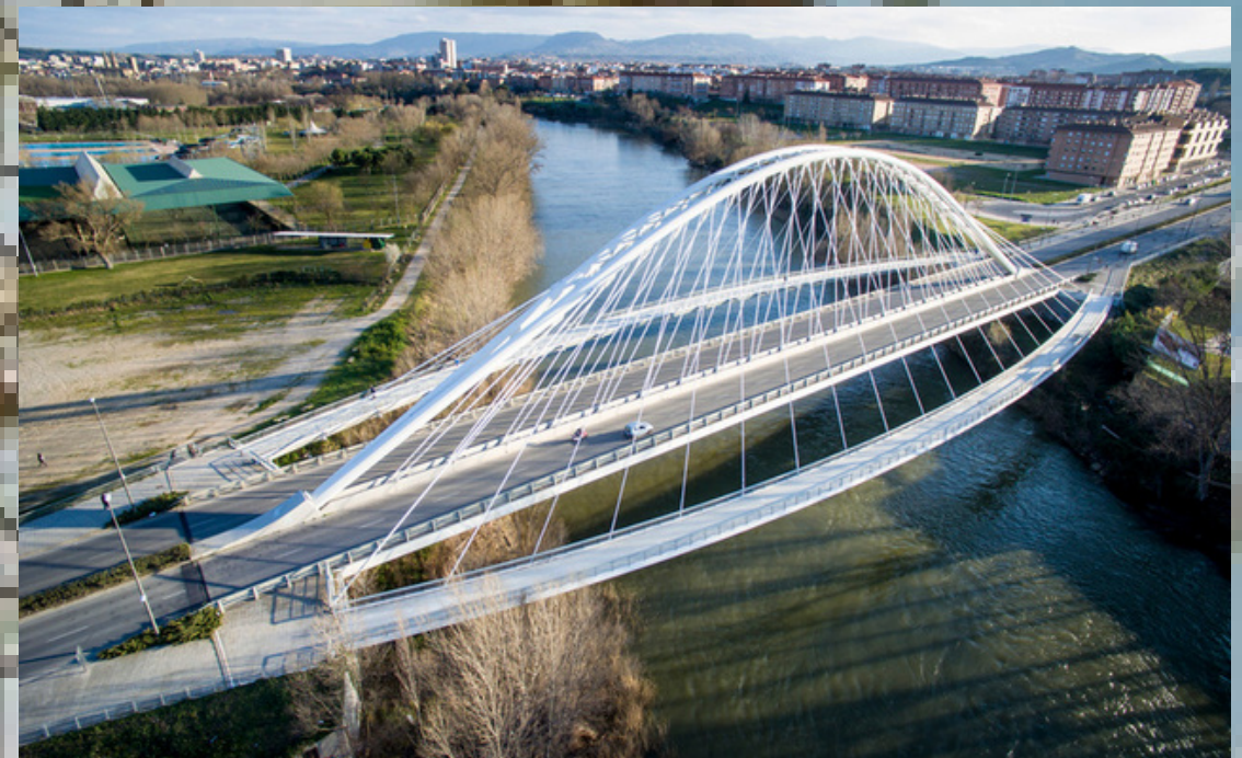
2002 - PUENTE PRÁXEDES MATEO SAGASTA
